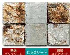
曝気槽にて2年間曝露試験を行ったテストピースの腐食状況比較
