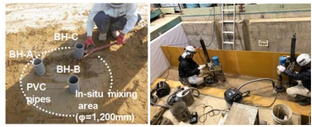
(a) 原位置機械攪拌 (b) 締固め安定処理 写真 2 測定孔の準備状況
