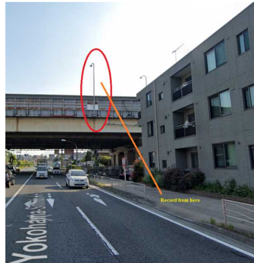
図 7 立体交差橋と照明柱
