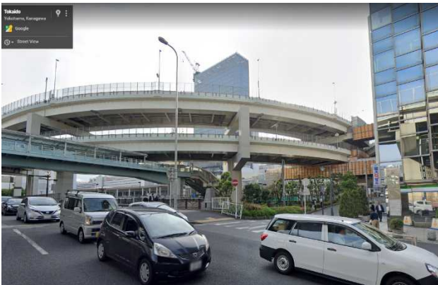
図10 計測対象として照明柱
