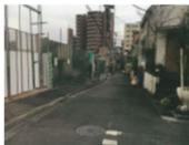
沿道状況(整備前)
