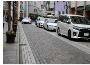
写真-3 石舗装による車道
