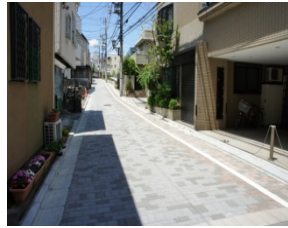
写真-6 沿道状況
