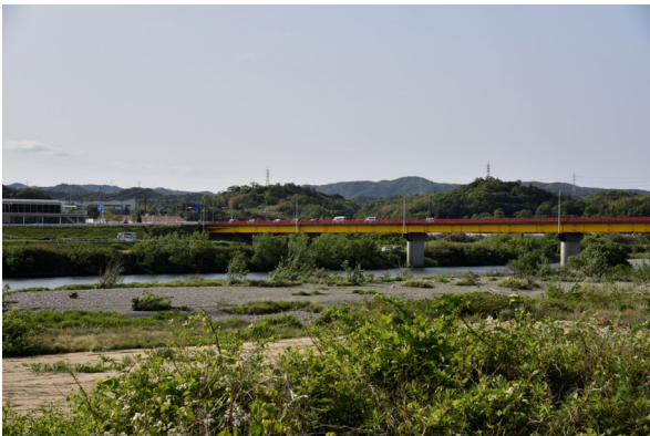
県道御坊美山線(御坊市)
