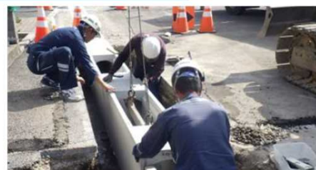
排水構造物設置の丁張りレス作業
