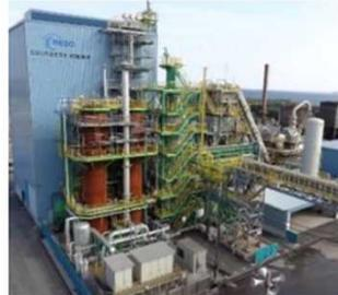
12m<sup>3</sup> 小規模試験高炉(水素還元)
