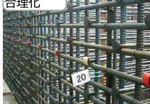
清水建設・Tヘッド工法鉄筋
