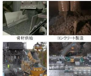
清水建設・ダムコンクリート自動打設システム
