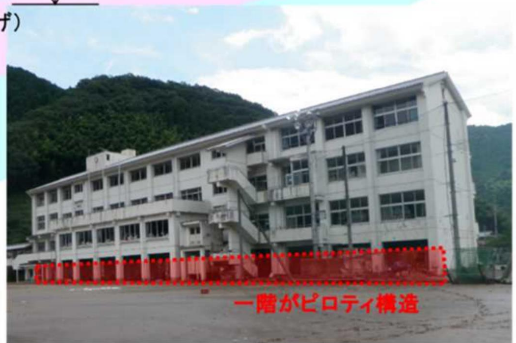
ピロティ構造の事例
