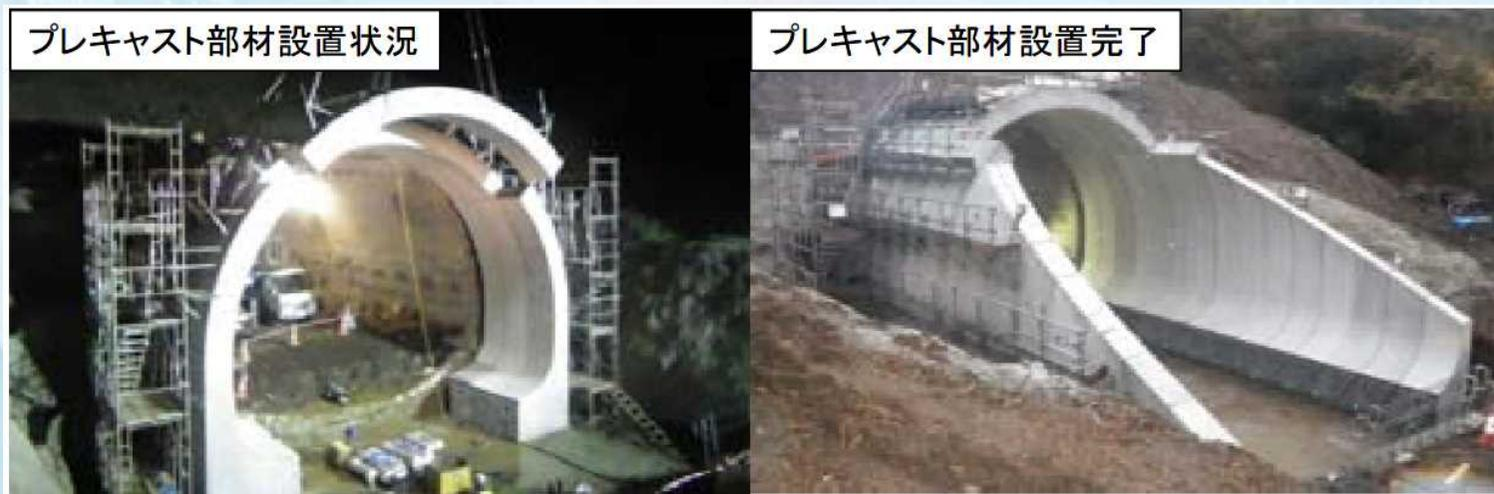
プレキャスト工法を用いた災害復旧工事の様子
