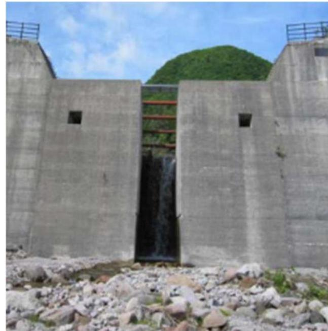
コンクリートスリット化した砂防堰堤
