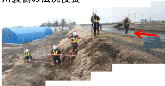
川裏側の法尻侵食
