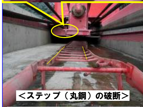
< 2号右岸階段損傷 >
