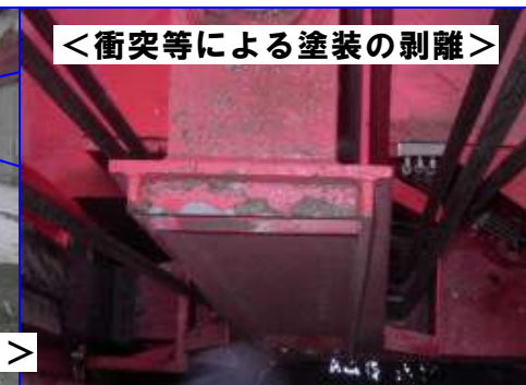
< 6号ゲート左岸堰柱への摩擦痕 >
