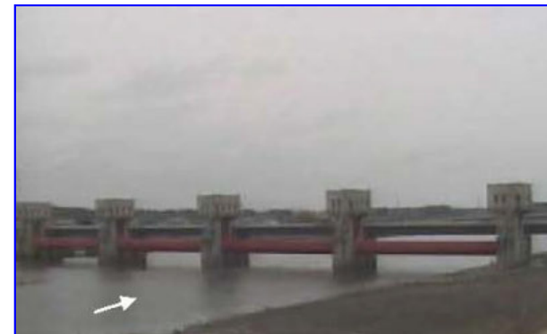
応急復旧後の状況
