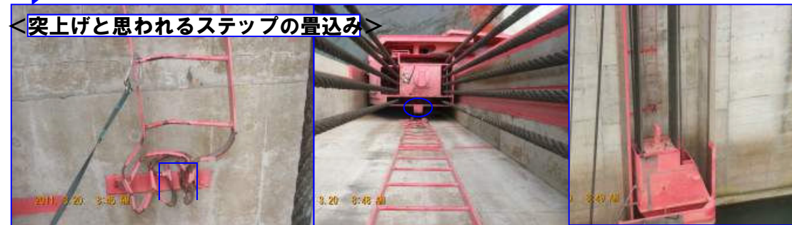
< 5号ゲート右岸階段の損傷 >
