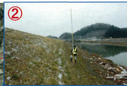
② 漂流物の状況。 (L4.6k付近)
