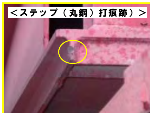
< 6号ゲート左岸堰柱への摩擦痕 >
