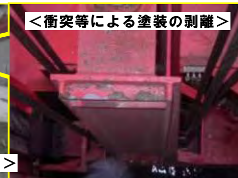
< 6号ゲート左岸堰柱への摩擦痕 >
