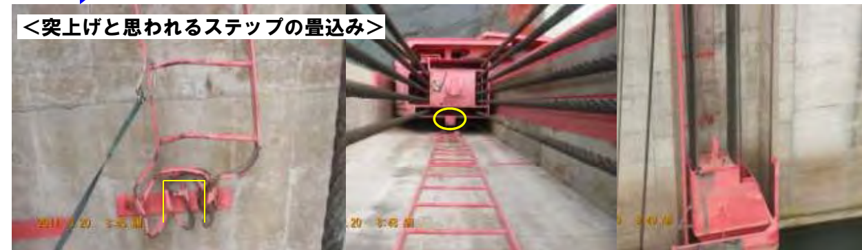
< 5号ゲート右岸階段の損傷 >
