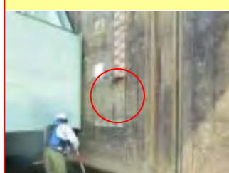
PG4: 量水標欠損
