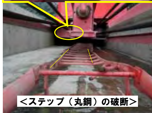
< 2号右岸階段損傷 >
