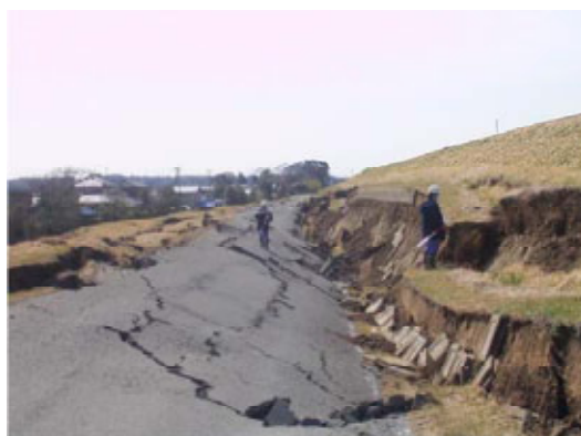
利根川下流（右）71k 付近 （千葉県印旛郡栄町） ※堤体も液状化している可能性
