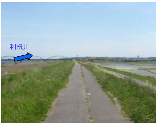
地震後の状況写真 (被災なし)
