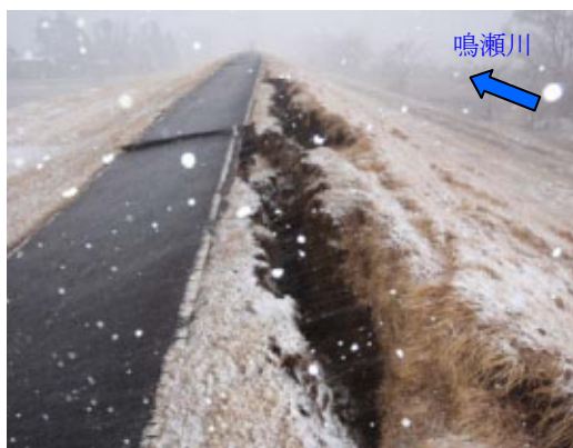
鳴瀬川（左）20k 付近 （宮城県遠田郡美里町和多田沼）
