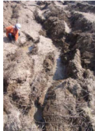
写真② 亀裂内は水がたまり、高含水の砂質土が充填されている
