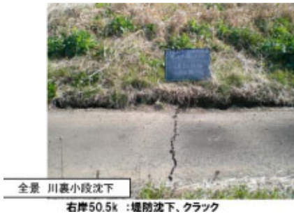
全景 川裏小段沈下 深さh=40cm 右岸50.6k-95m~50.6k-68m:堤防亀裂
