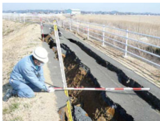
潤沼川（左）7.5k 付近 （茨城県東茨城郡下石崎地先）
