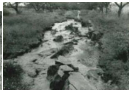
真野代:写真③(川裏のり尻)
