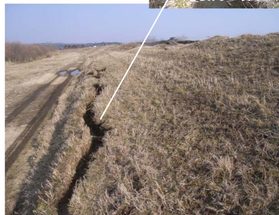
亀裂内の噴砂痕 (江合川 左岸14.0k+43～14.6k+43)
