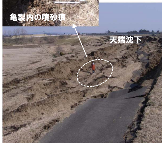
天端沈下 — 亀裂内の噴砂痕 (鳴瀬川 左岸30.0k～30.5k+37)
