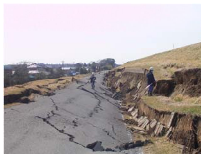
利根川下流(右)71k付近 (千葉県印旛郡栄町) *堤体も部分液状している可能性
