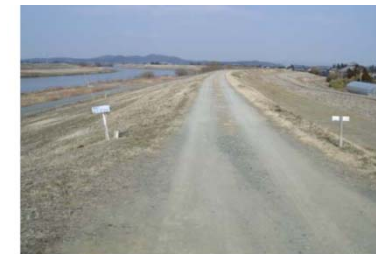
今回の地震後の状況(対策工部に変状なし)
