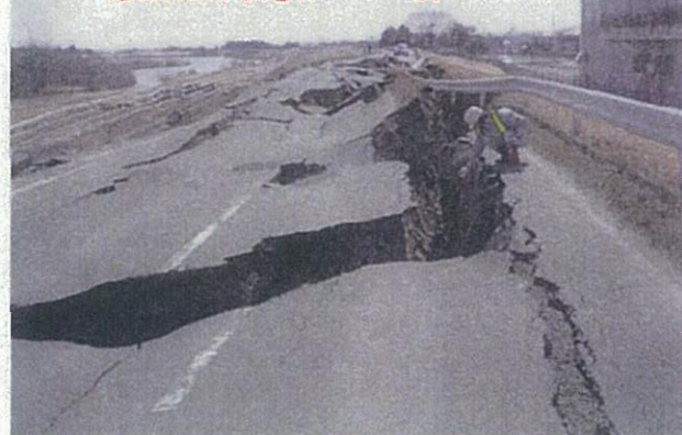
写真①天端には深度2.0m以上のクラック (裏法は形状を保っている)
