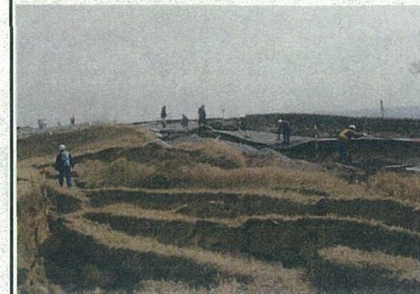
②川裏法面状況：縦断クラック発生 深さは20~100cm程度である。
