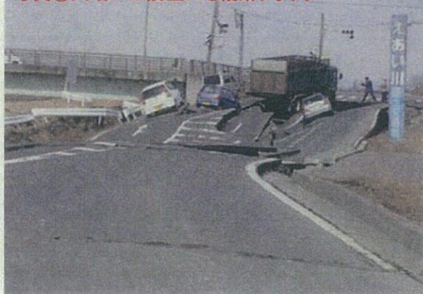
写真①天端には幾重にも縦断クラック
