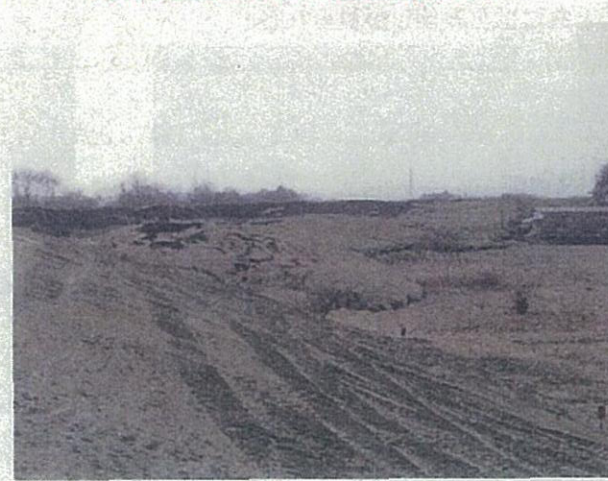
写真③ 裏法のはらみだしが見られる
