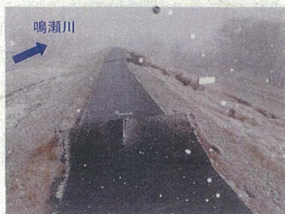
写真①: 天端に沈下による横断クラック
