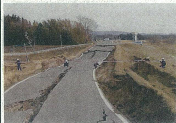
①全景 縦断方向のクラックが多数確認される。
