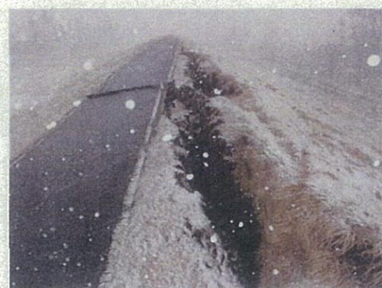
写真②: 堤内法肩に縦断クラック L=150m
