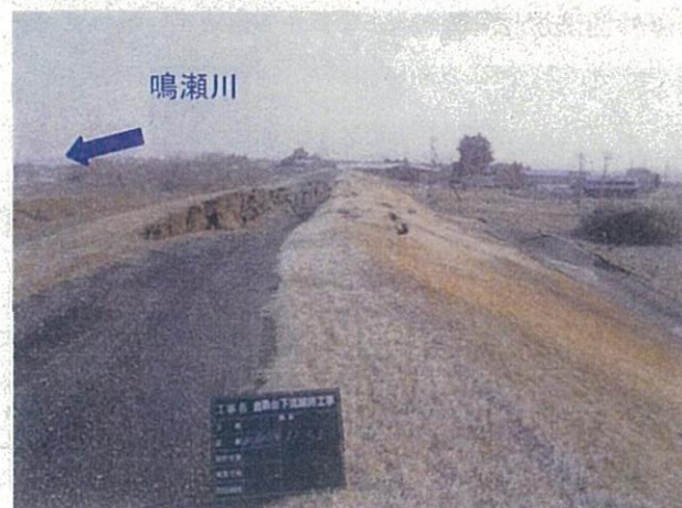
写真①天端が沈下し、縦断クラックは裏法に幾重にも発生している
