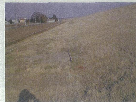
写真③裏法小段の噴砂
