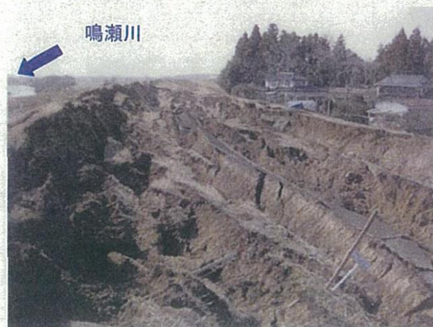
写真① 裏法は幾重にも縦断クラックが発生するとともにほらみだしが見られる
