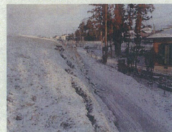
写真④: 川裏法尻にはらみだしおよびクラックが見られる
