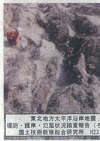
写真② クラック内は水たまり、高含水の砂質土が充填されている
