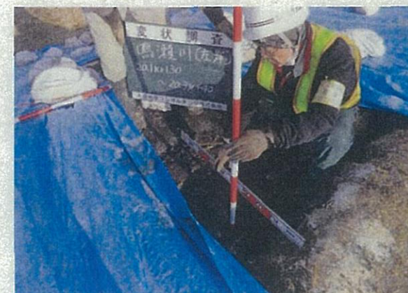
写真③: 堤内法肩縦断クラック(近景) L=150m W=30cm H=50cm
