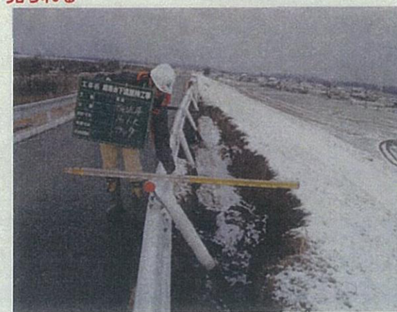
写真③裏法肩に縦断クラック、裏法はらみだしが 見られる
