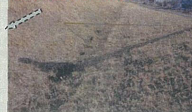
写真④裏のり小段の噴砂。小段尻は沈下している。
