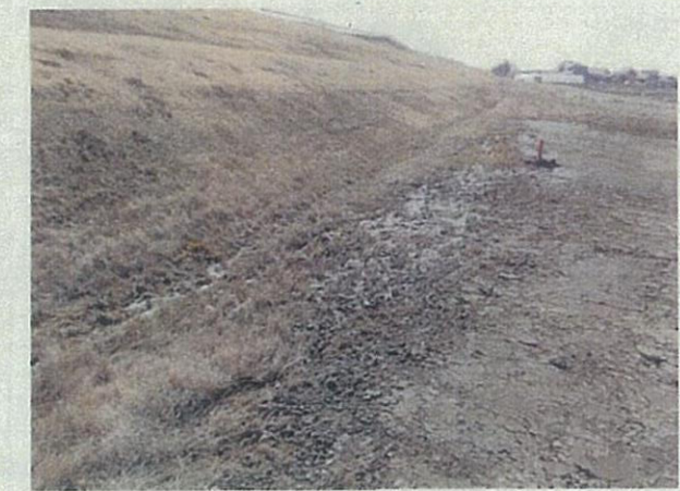
写真④裏法尻にはしみだしが見られる
