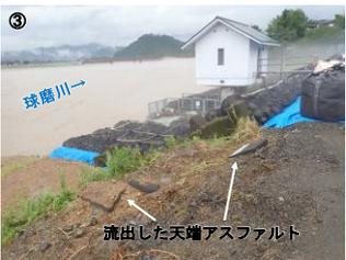
図 2-22 天端アスファルトの流出
