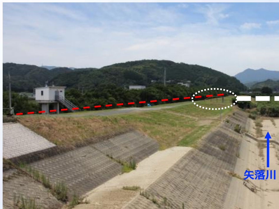
越流が生じた暫々定堤防箇所に損傷等は見られない
