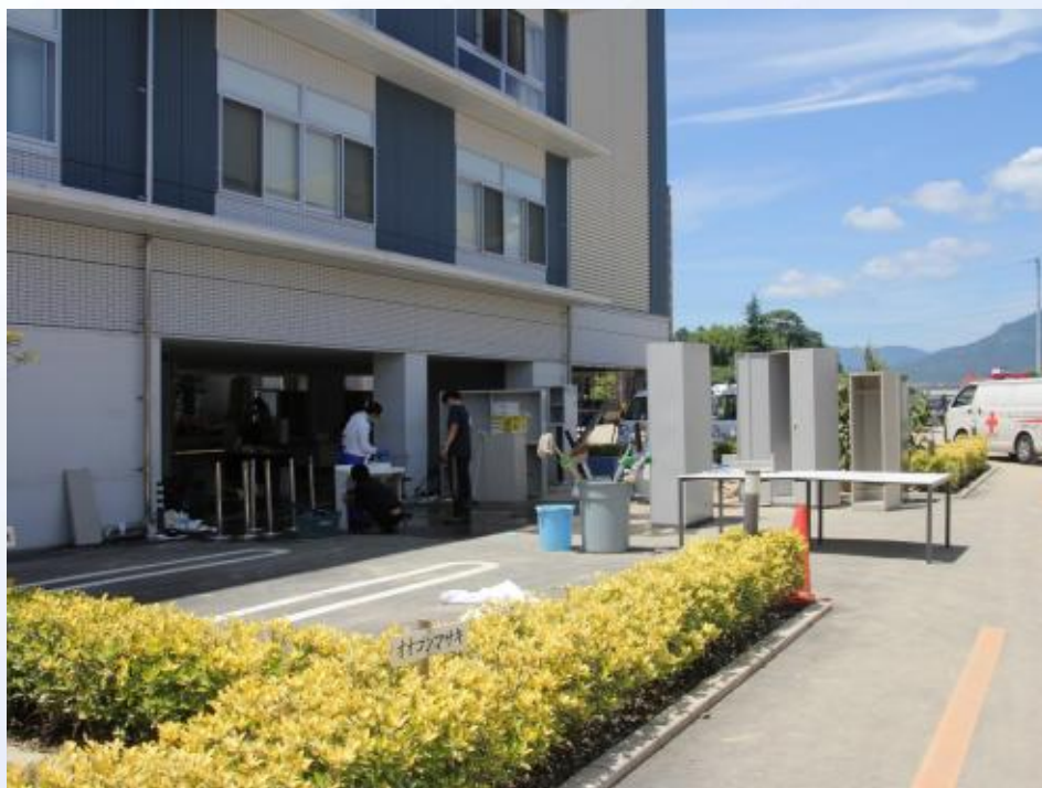
1階の半分程度がピロティー構造となっている
