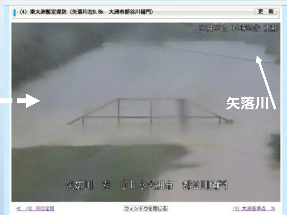
暫々定堤防の越流時の状況
