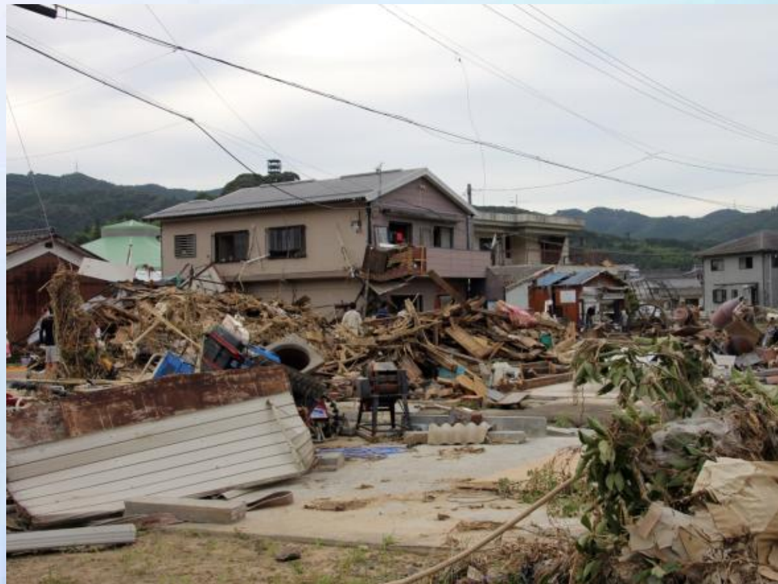
住宅の被災状況。多くの漂流物と土砂が堆積している（肱川右岸）
