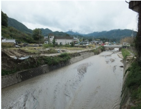
①下流部河道掘削状況
