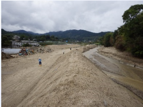
③掘削土砂の仮置き
