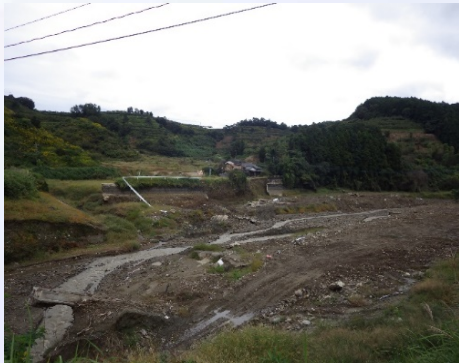
③崩壊溜池上流護岸及び家屋損傷
