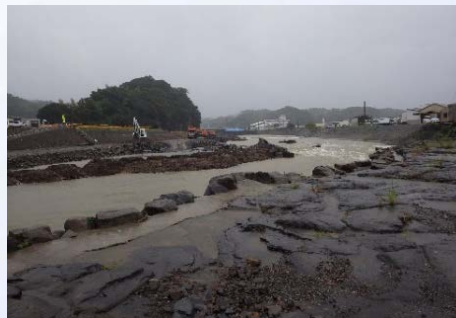
①筑後川合流点付近復旧状況
