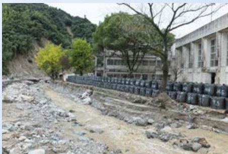
④末松小学校土嚢対策
