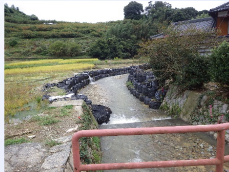
②民家の護岸も応急復旧済み
