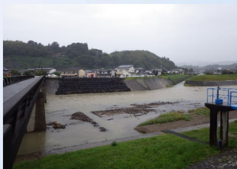
②JR久大線鉄道橋 撤去状況
