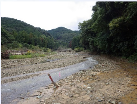
③桂川上流端土砂堆積状況
