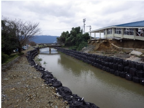
①学校の護岸応急復旧済み
