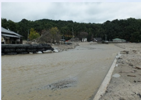
⑤薄い河道掘削
