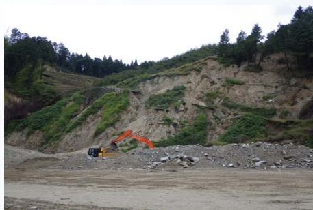
①崩壊斜面
