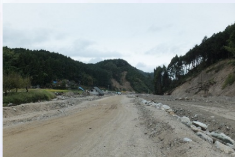
③工事用仮設道路
