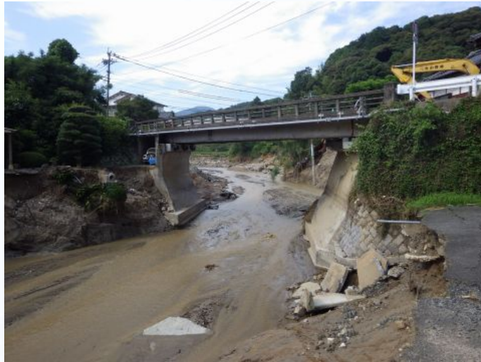
下流から橋梁と上流の湾曲部をみた様子。
