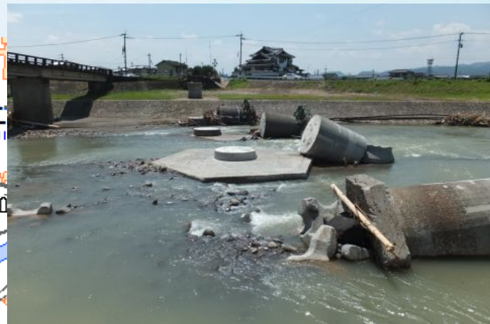
右岸から撮影。手前1脚は基礎から転倒、奥の3脚は折損。
