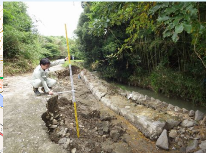
右岸側の護岸背面の侵食状況。
