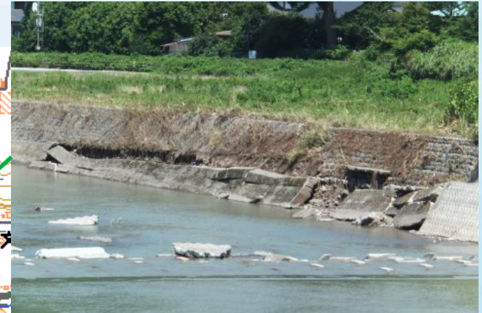
床止め下流の低水護岸の被害箇所。
