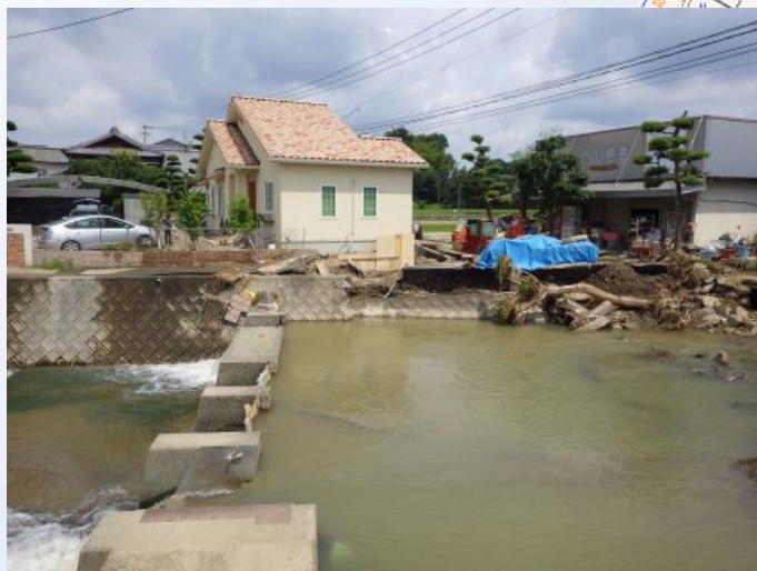
農業用取水堰の上流は局所的に川幅が拡大。
