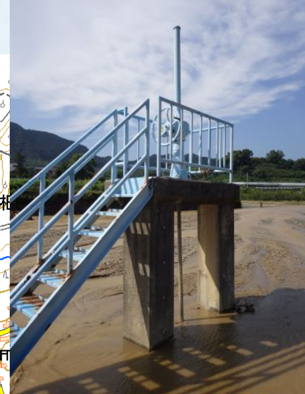
樋管は土砂に埋まり、スピンドルが傾いた状態。
