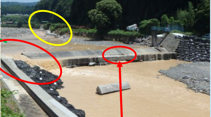
6.4k地点の堰の右岸が損傷。
