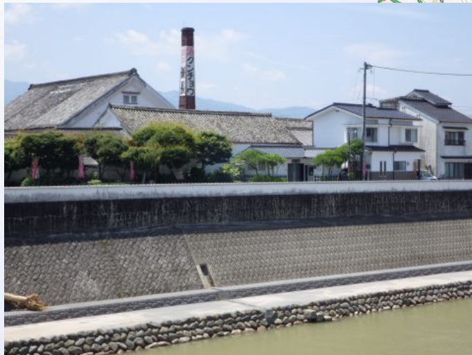
日田市街地周辺の護岸は被害がみられない。
