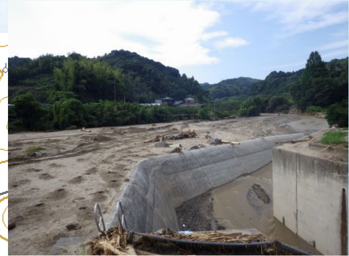
土砂により埋没したため池(?)。
