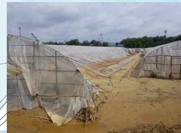
氾濫流により押し潰されたビニールハウス。
