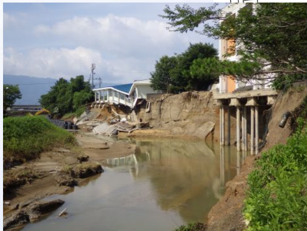
湾曲部外岸が侵食し、内岸に土砂が堆積。
