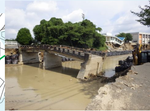
橋梁の左岸取り付け部が侵食され、橋脚も傾倒。
