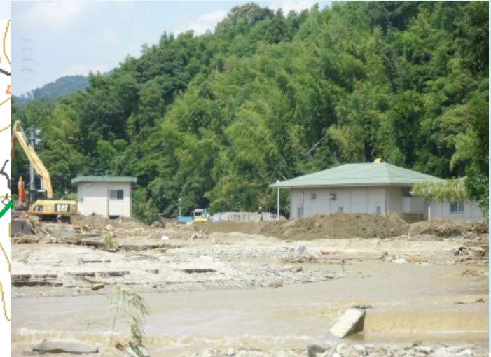
上流左岸、湾曲部外岸側の浄水場に土砂と流木が堆積。
