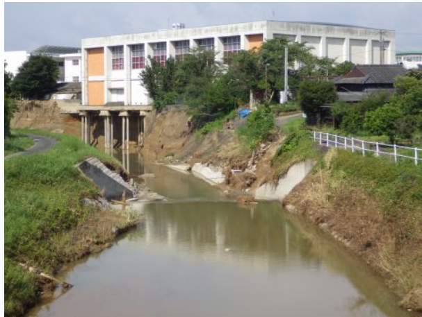
上流から床止め工、学校の体育館をみた様子。
