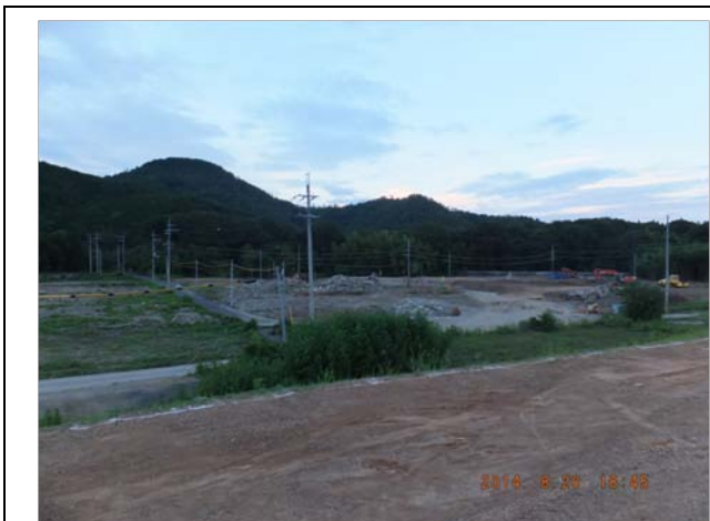
a. 旧戸田地区には電柱が残り、重機によって整地作業が進められていた。旧戸田地区、移転先、堤防法線については図 - 14 を参照のこと。
