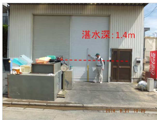
l. 地点 k. 近傍の建物の浸水痕跡
