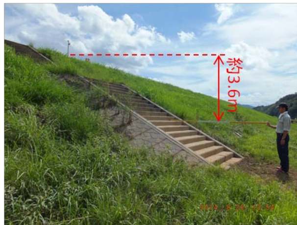
f. 蓼原川樋門に残る洪水痕跡（堤内地側）。最高水位は堤外地側よりも高い。
