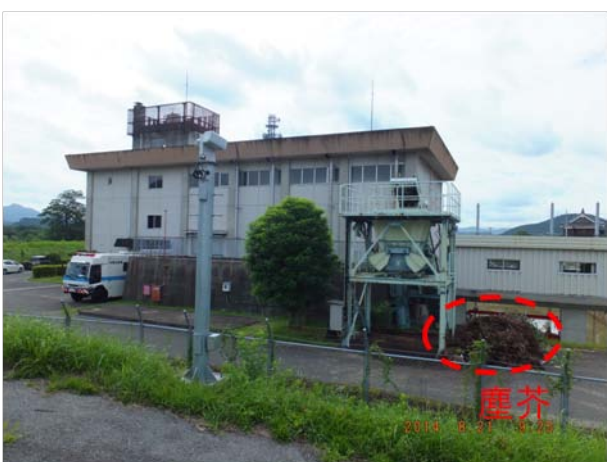
2) スクリーンで捕捉された塵芥が残されていた。
