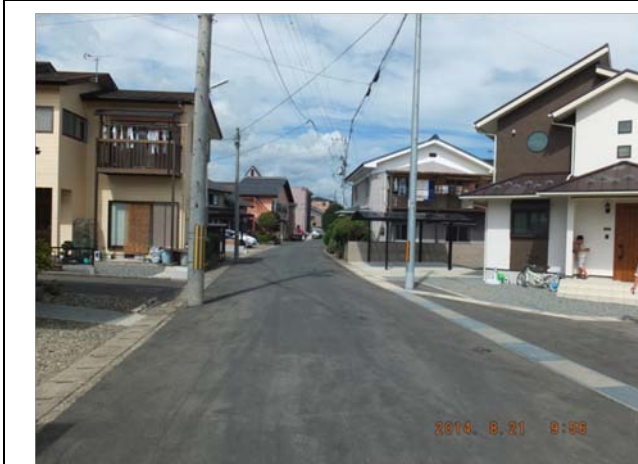
i. 地点 h. よりもさらに河川堤防から離れると, 床下浸水程度であり, 浸水痕跡を確認することはできなかった。
