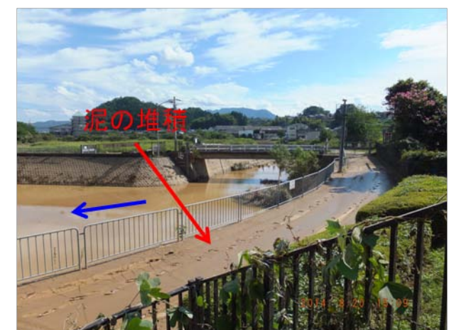
2) 沈砂池周辺に堆積する厚さ 10cm 程度の泥。奥に見えるのが弘法川。中央付近の橋梁左岸側で 2.3m の湛水深を確認している。
