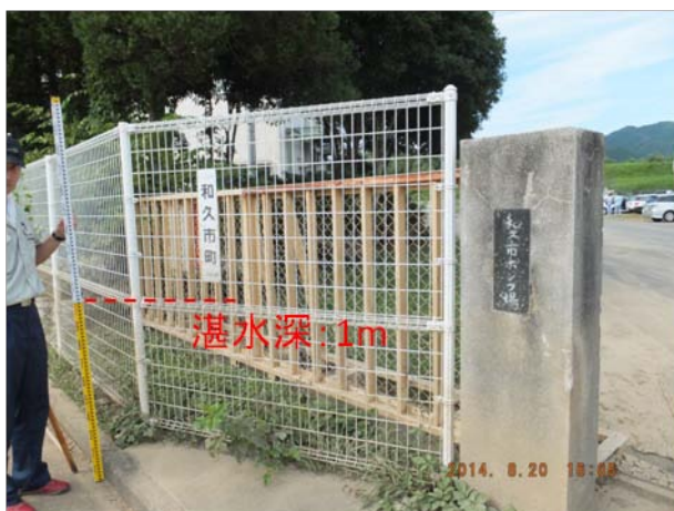
o. 和久市排水ポンプ場入口脇で確認した浸水痕跡
