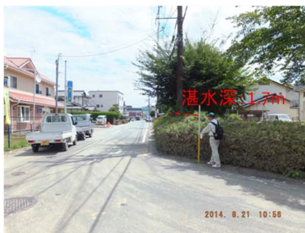
bb. 集会場からさらに土師川方面に向かった地点の浸水痕跡
