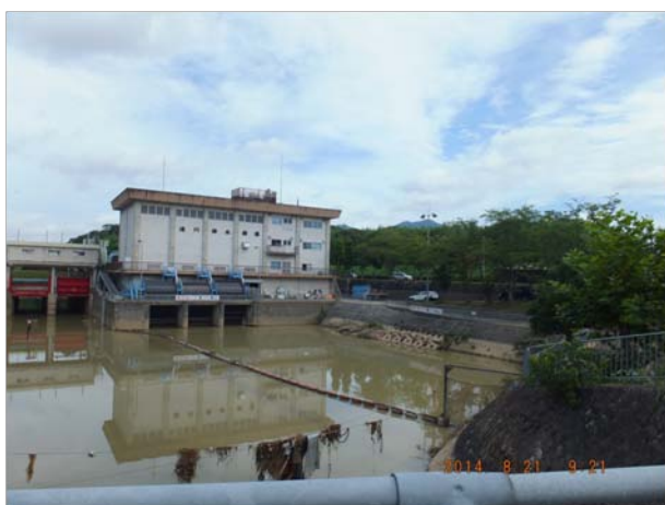
1) 法川排水機場の外観。沈砂池には濁水が残る。
