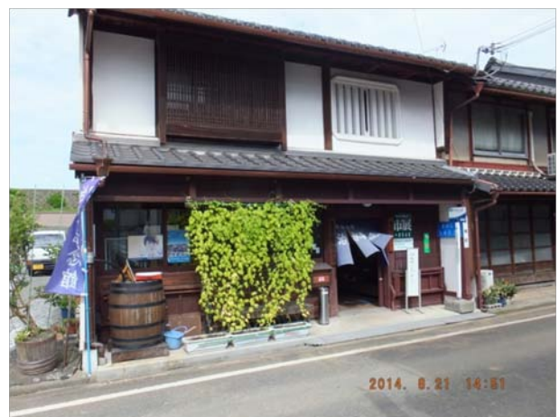
zz. 路地にある治水記念館では床下浸水とのことであったが、浸水痕跡は確認できなかった。治水記念館の方の話だと、下水から溢れ出し、その後周辺からも浸水したとのこと。浸水に伴う汚れは既に清掃したとのことであった。
