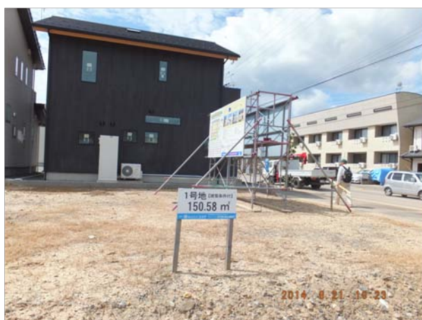
o. 弘法川沿川でも宅地が開発され、新築住宅が販売されていたが、床上浸水が確認された。
