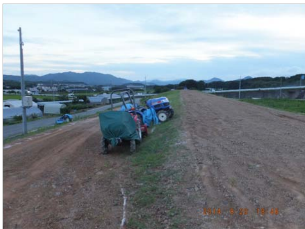
c. 堤防上に待避された農業機械。堤防は整備中であり、部分的に全く整備されていない区間があったが、河川からの浸水は確認できなかった。
