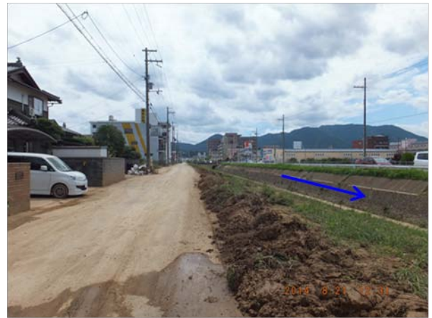
x. 弘法川の河岸に沿って土砂が積まれていた。沿川に多量の土砂が流出したことを推測できる。
