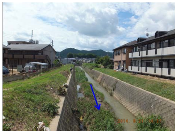
t. 法川の上流を望む。土砂の顕著な堆積や植生の倒伏は見られない。
