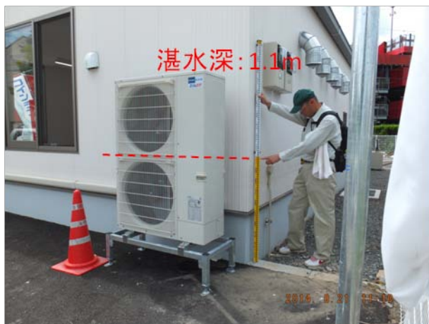
ii. 地点 hh. から県道 55 号を法川排水機場方面に行くと、徐々に湛水深が大きくなる。コインランドリーは床上浸水のため清掃中。機器の半分が湛水したエアコンの室外ユニットは作動していた。
