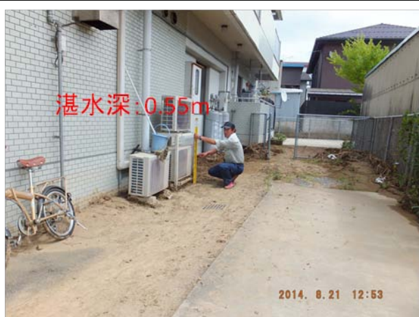
gg. 弘法川沿川で確認した浸水痕跡
