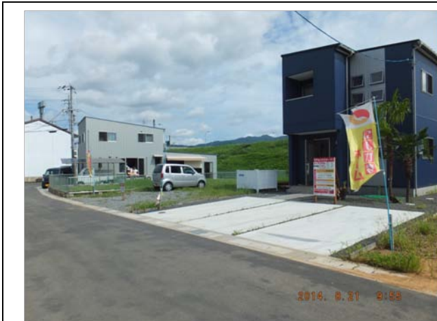
g. 堤防脇に開発された宅地, 及び新築された住宅。新築住宅でも床上浸水が生じていた。
