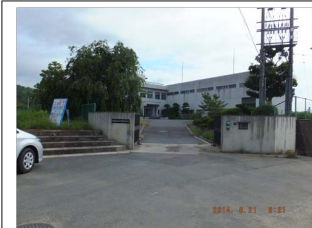
1) 管理事務所の外観。事務所のある戸田地区も浸水しておらず、一段高い事務所にも浸水痕跡を確認できなかった。
