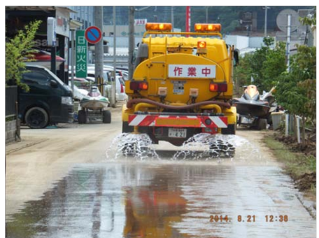
z. 散水車による水撒き作業。晴天が続いたため、路面上に堆積した土砂の飛散を防止するため実施されていた。
