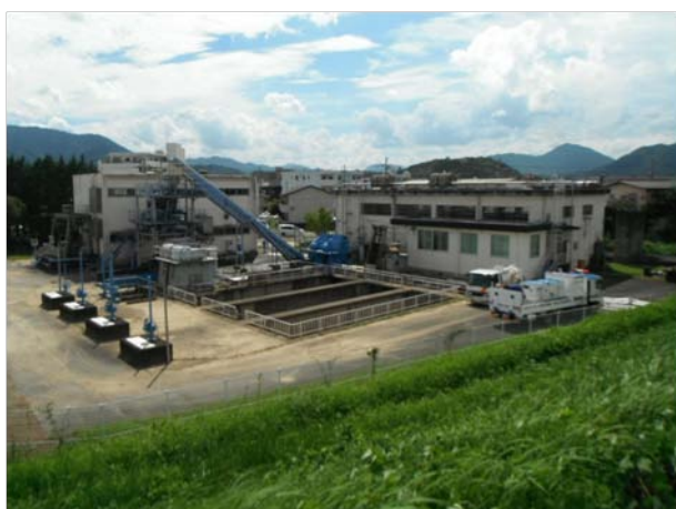
1) 和久市排水ポンプ場の外観。浸水によってポンプ4台が故障した。
