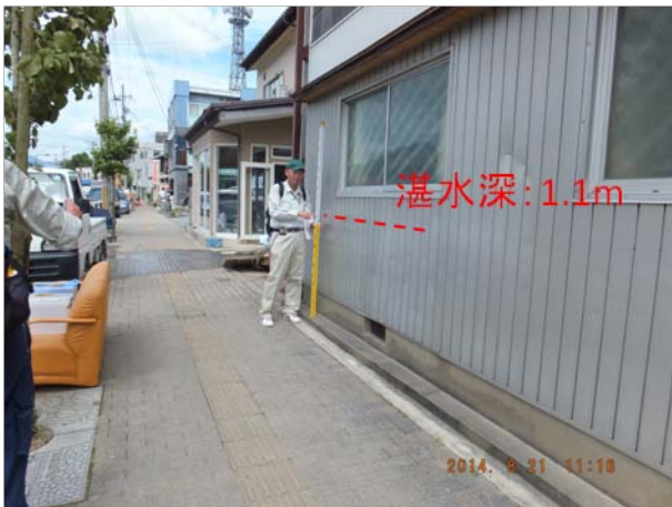
mm. 県道 55 号線脇の浸水痕跡。蛇ノ端ポンプ所から福知山河川国道事務所へ向かった地点。
