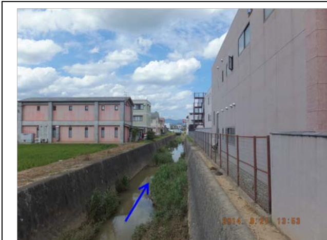
oo. 西川には土砂の堆積を確認できない。
