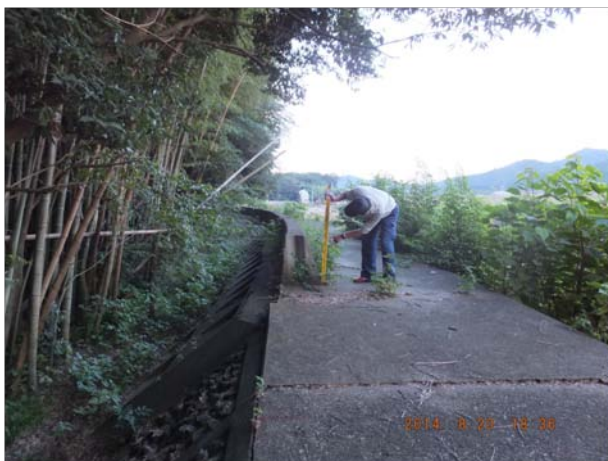
e. 旧堤防ののり肩に設置された高さ 55cm のパラペット (地点 d. の上流側)。戸田地区上流からの越水が始まることを避け、下流から徐々に湛水させる構造としたものと考えられた。
