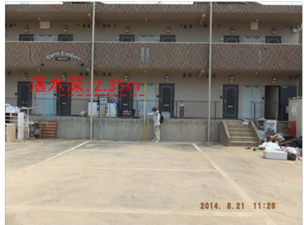
rr. ゆらのガーデン駐車場から山陰本線に向かった地点の浸水痕跡
