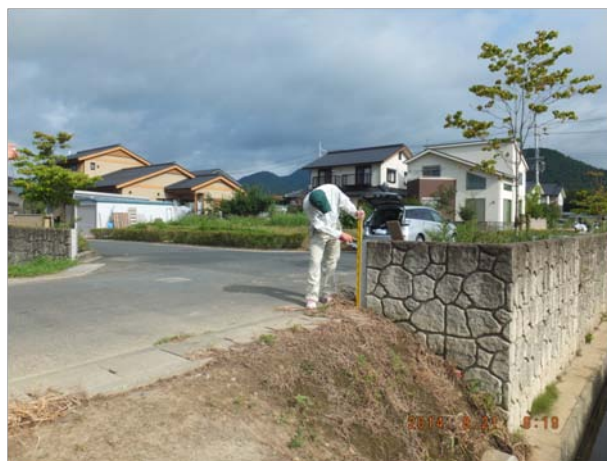
f. 移転先の戸田地区を囲む浸水防止壁。高さは 75cm 程度。開口部には浸水防止板をはめ込むために溝がある。
