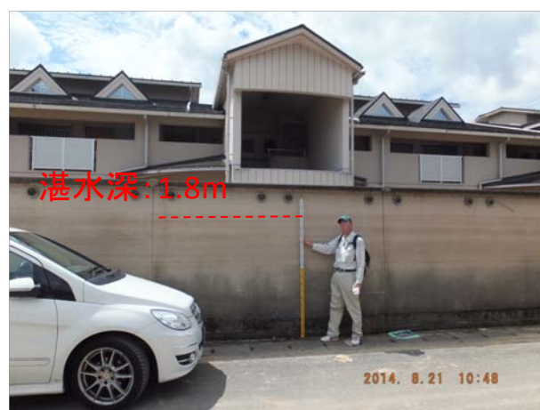
x. 地点 w.奥に見える壁の浸水痕跡
