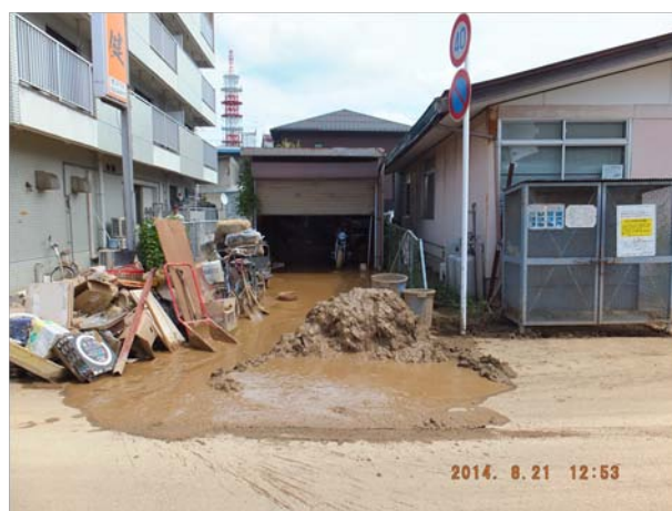
ff. 清掃がこれからと思われる宅地には水を多量に含んだ土砂で一面覆われていた。厚さは10cm 程度。
