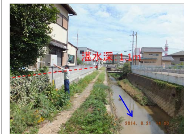
ss. 河岸天端が 1m 以上冠水しているが、植物の倒伏は見られない。流れはそれほど速くなかったと推測される。
