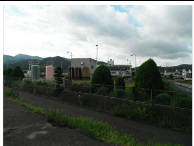
2) 河川側から見た浄水場の外観
