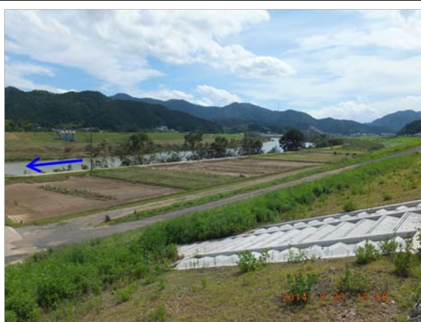
f. 蓼原川樋門に残る洪水痕跡（堤内地側）。最高水位は堤外地側よりも高い。
