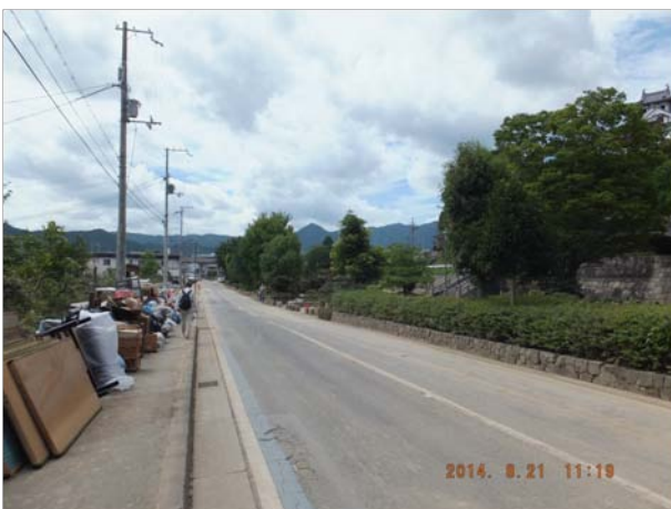
oo. 福知山河川国道事務所前交差点からゆらのガーデン方面を望む。地盤高が徐々に低くなっていることを確認できる。
