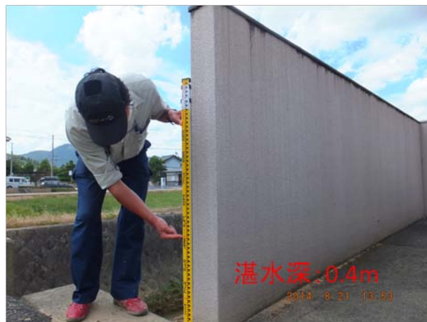
pp. 西川河岸際で確認した浸水痕跡
