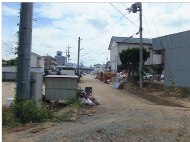
s. 細い道路では泥やゴミの除去が遅れていた。
