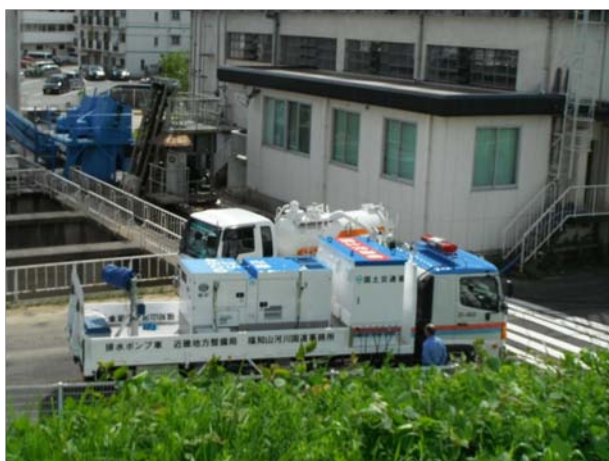
3) 故障したポンプの機能を補うため、排水ポンプ車が配置されていた。
