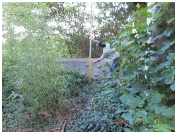
d. 低水路脇の竹林の中に残る旧堤防。越流しても壊れにくいようにと推定されるが、裏のりもコンクリートで被覆されていた。
