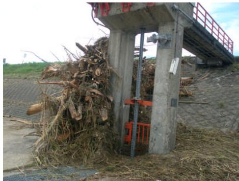
左岸 108付近(魚沼市堀之内 堀之内水位観測所) 手摺・配管損傷
