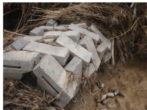
左岸 45付近(長岡市川口) 低水護岸裏洗掘
