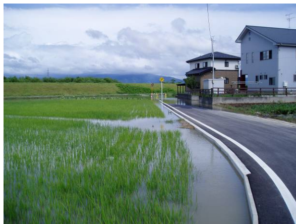
早出川 R2.0k 堤内地浸水状況
