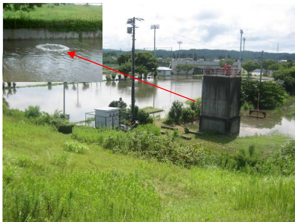
L22.2k 付近 堤内地の浸水状況
