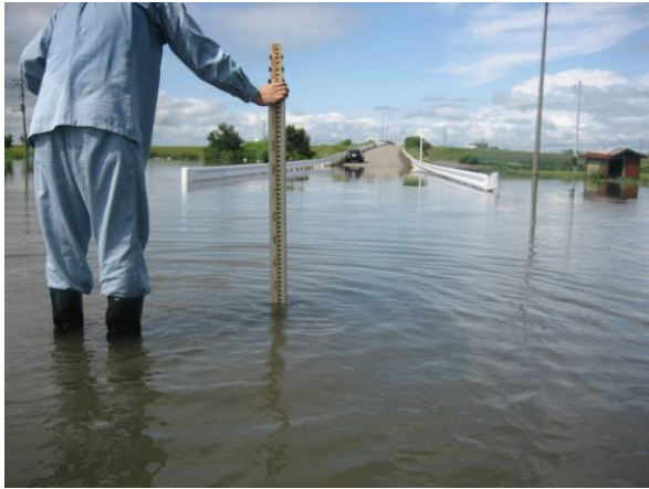
早出川支川太田川（五泉市太田） 堤防際道路冠水状況
