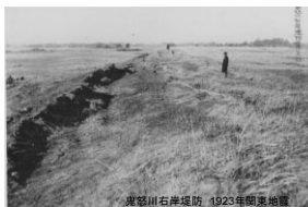
鬼怒川右岸堤防 1923年関東地震
