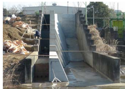
写真-2 高落差実験水路（縮尺 1/2）
