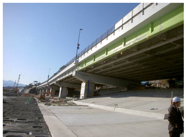
金波橋復旧状況
