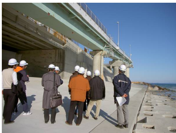
銀波橋復旧状況
