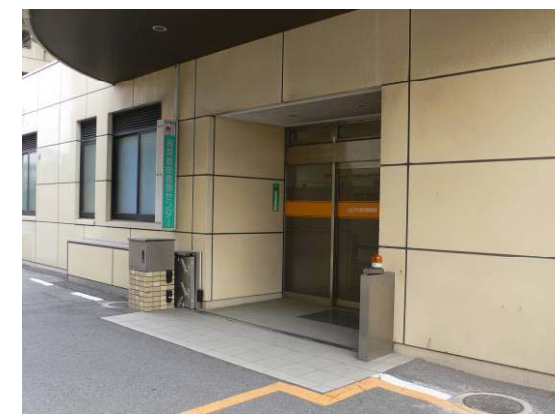
止水板の設置(病院)
