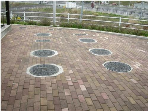
写真-11 使用された災害用貯留型マンホールトイレ
