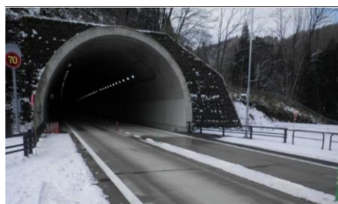
出所：NEXCO 東日本 図 4-6-4 ヒートポンプ方式による路面融雪の事例(秋田自動車道)
