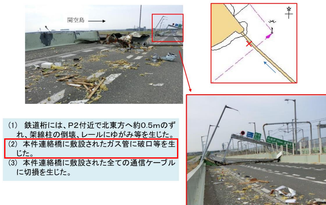
図 5-5-2 関西国際空港連絡橋へのタンカーの衝突事故時における道路の損傷状況
