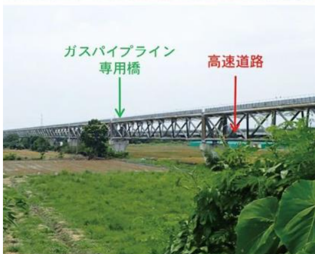
図-4 河川を横断するガスパイプライン専用橋
