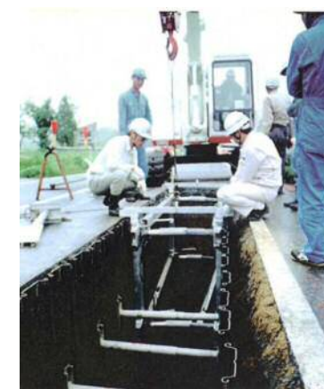
簡易自動切梁装置
