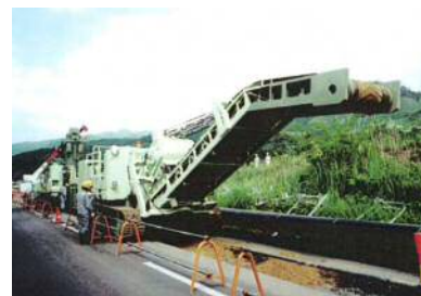
連続溝掘削機
