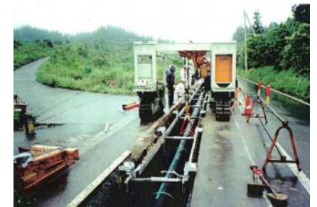
パイプ吊下しクレーン
