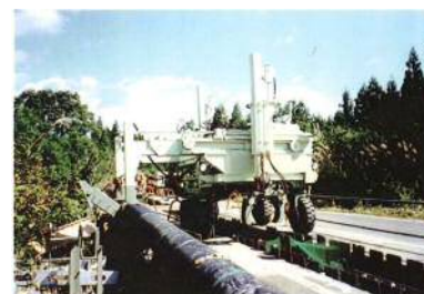
パイプ敷設クレーン
