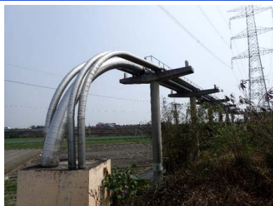
右岸側の地中埋設からの専用橋への露出部
