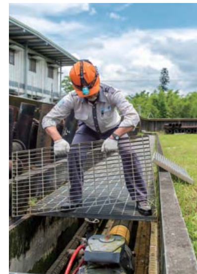
高速道路1号線からの天然ガスの引込導管とその保守作業(CPC社提供)
