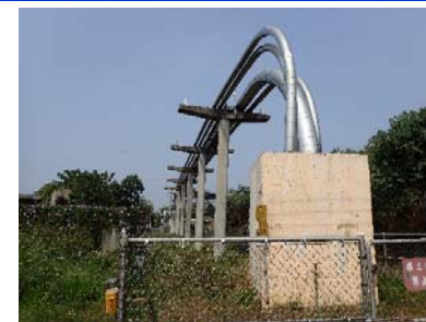
左岸側の地中埋設からの専用橋への露出部
