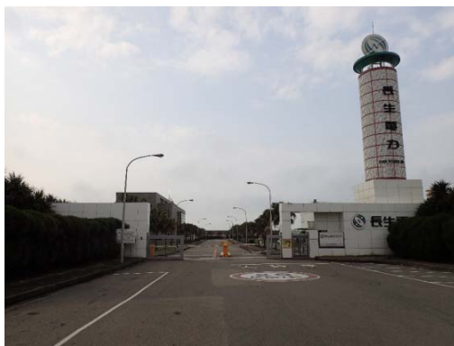
長生ガス火力発電所(正面)
