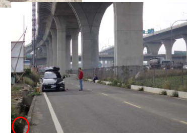
ガス管埋設の表示
