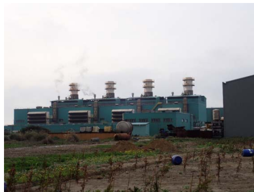
長生ガス火力発電所(東側)
