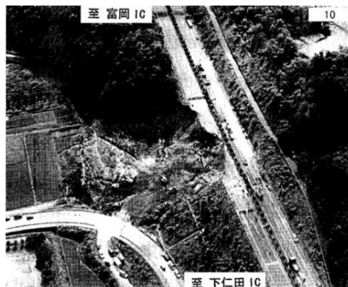
写真 5.1 斜面崩壊状況
