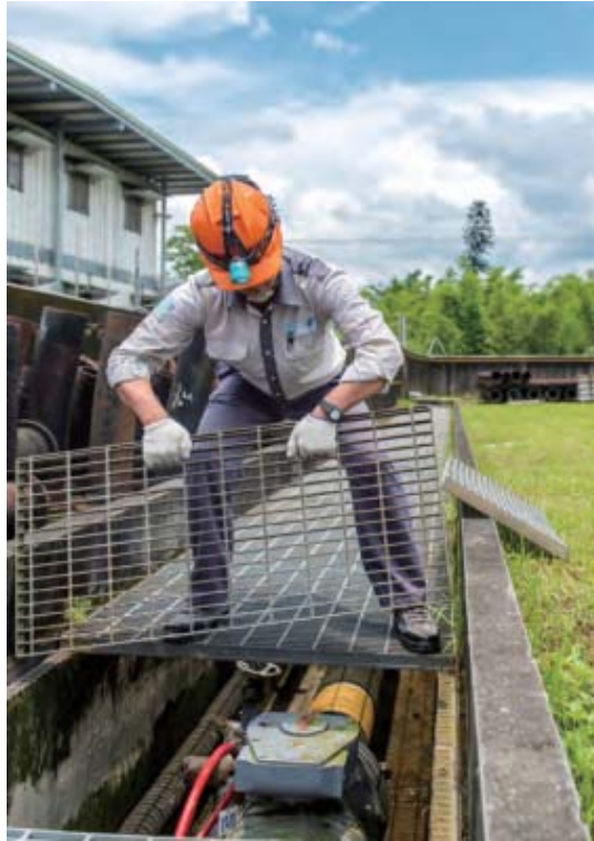
参考写真 3.13 高速道路1号線からの天然ガスの引込導管とその保守作業（CPC 社提供）
