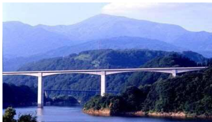
写真 8.1 橋梁部（河川横断）
