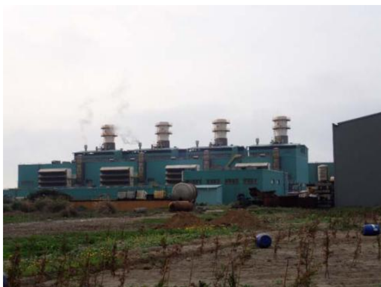
参考写真 3.12 長生ガス発電所（東側）
