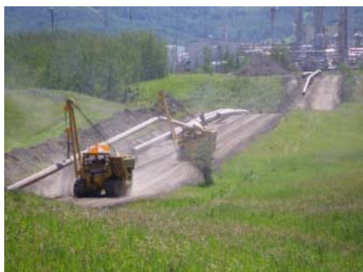
図 4.6 スプレッド工法の工事例（カナダ）
