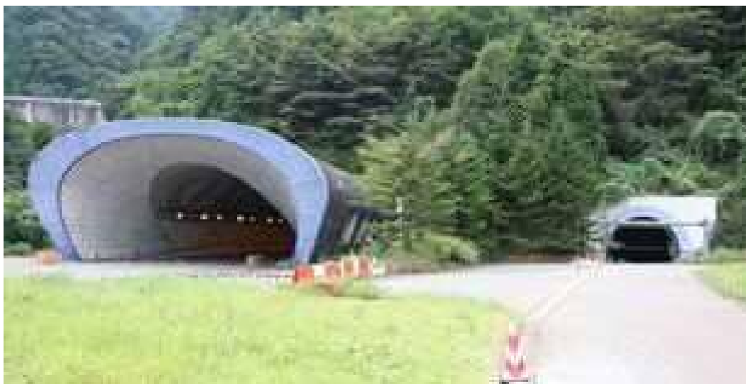
写真 8.3 トンネル坑口部（左側 本坑、右側 避難坑）
