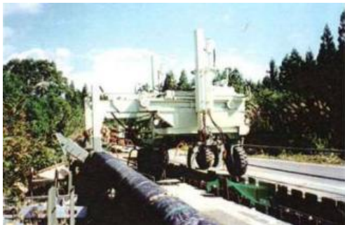
(3) パイプ敷設クレーン
