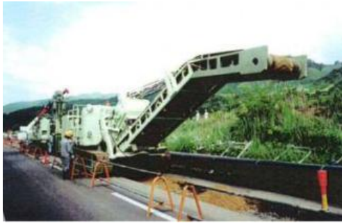
(1) 連続溝掘削機
