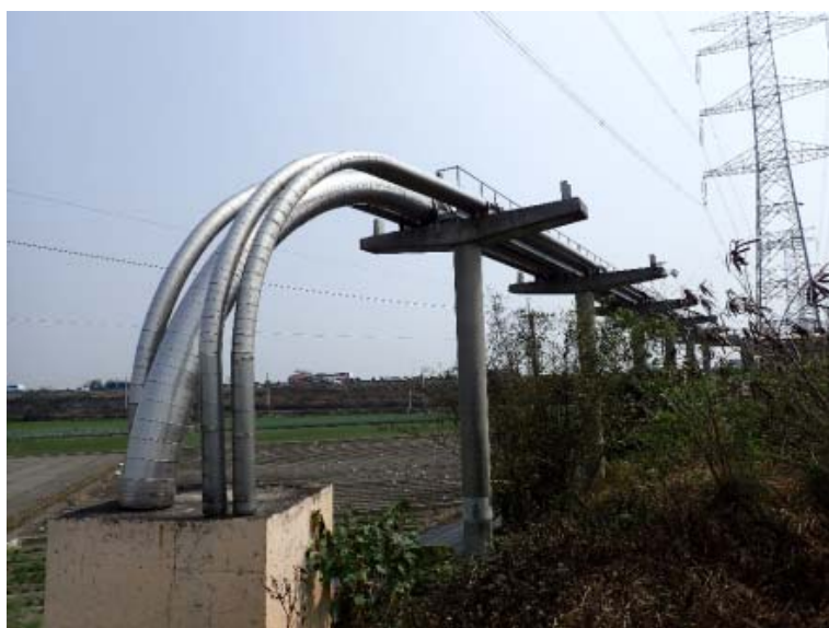
参考写真 3.6 右岸側の露出部
