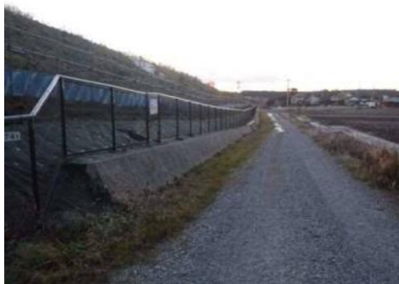
写真 11.1 本体盛土脇の側道（未舗装）
