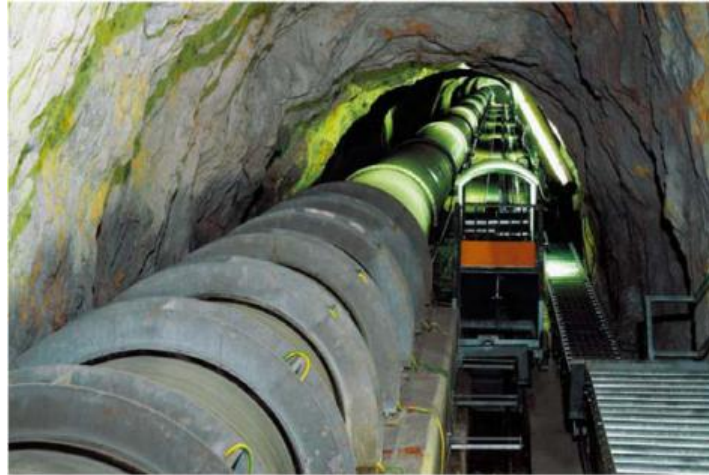
図 4.26 山岳トンネル坑内の様子
