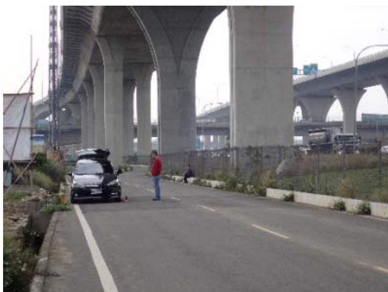
参考写真 3.1 埋設箇所（遠景）
