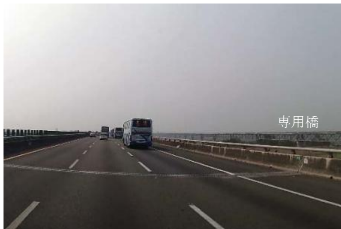
参考写真 3.3 ドライブレコーダによる高速道路と並行する高圧導管専用橋
