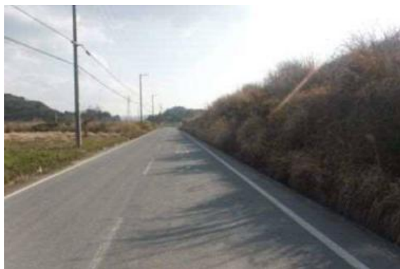
写真 11.2 本体盛土脇の側道（舗装有）
