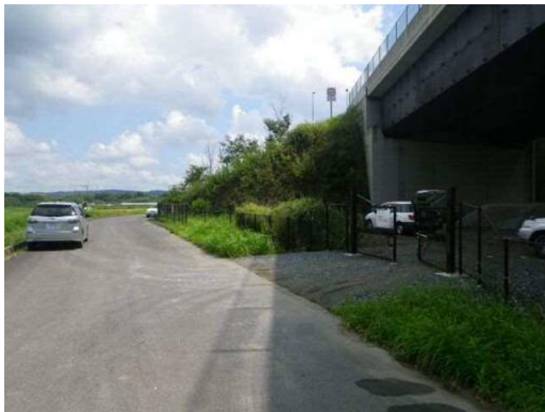
写真 11.4 高架脇の側道
