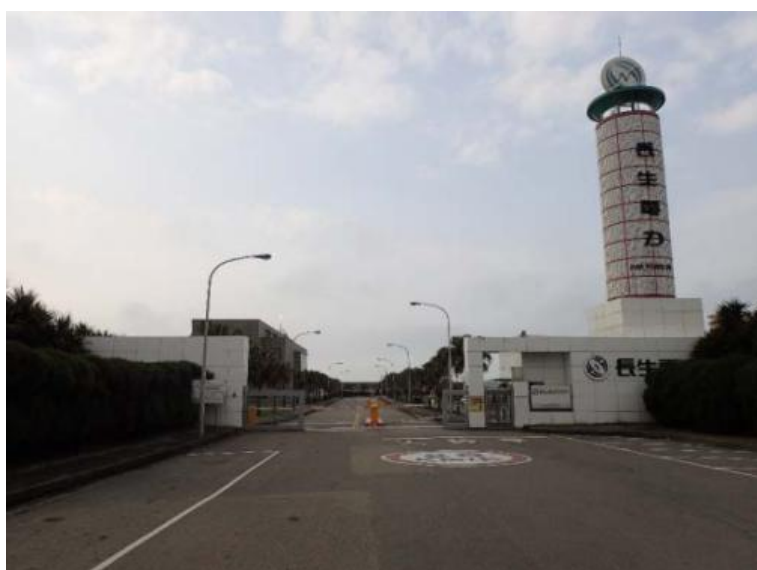
参考写真 3.11 長生ガス火力発電所（正面）
