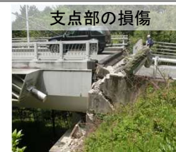
写真-6 熊本高森線 （桑鶴大橋）
