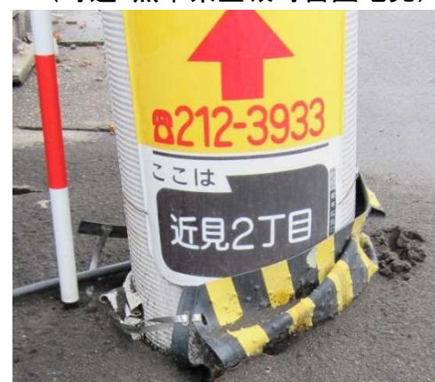
写真-13 電柱の沈下やマンホールの浮き上がり及び周辺地盤の沈下 (左:町道・熊本市南区近見地先、右:町道・熊本県益城町寺迫地先) ※ 2 電柱の被害本数は、総務省、経済産業省調べ(平成28年6月6日時点) 倒壊本数には、土砂崩壊等によって倒壊した本数も含む。
