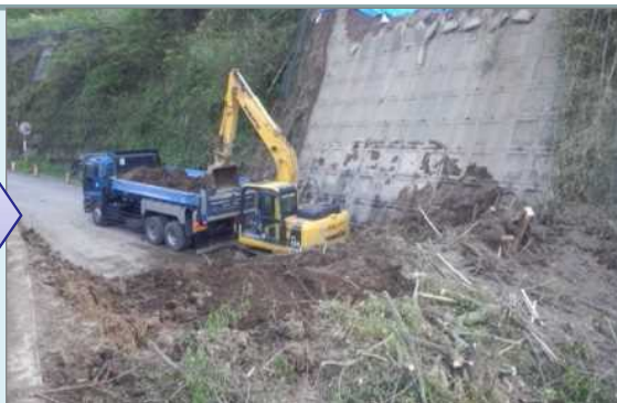
■重機による道路啓開作業を実施
