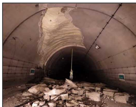
写真-16 俵山トンネル(県道) たわらやま
