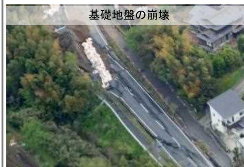
写真-9 国道443号（益城町）
