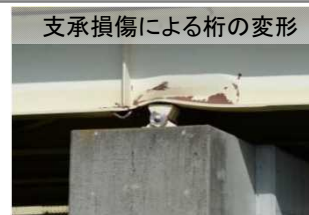
写真-5 九州自動車道 （木山川橋）
