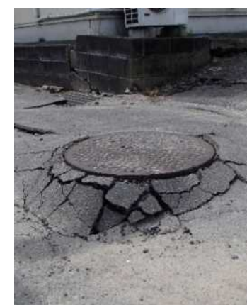
写真-13 電柱の沈下やマンホールの浮き上がり及び周辺地盤の沈下 (左:町道・熊本市南区近見地先、右:町道・熊本県益城町寺迫地先) ※ 2 電柱の被害本数は、総務省、経済産業省調べ(平成28年6月6日時点) 倒壊本数には、土砂崩壊等によって倒壊した本数も含む。
