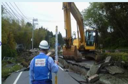
■重機による盛土復旧作業を実施
