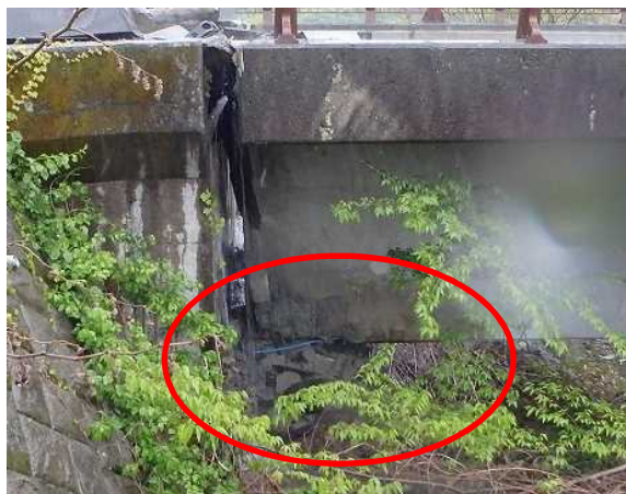
写真-1 橋梁周辺での大規模な斜面崩壊(上) A2橋台側桁端部の損傷(下) あそ ちようよう (村道栃の木～立野線・阿蘇長陽大橋)
