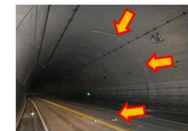
写真-2 覆工コンクリートのひび割れ（南阿蘇トンネル）
