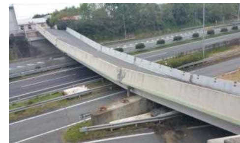
写真-3 おがわかしま 府領第一橋の落橋 県道小川嘉島線
