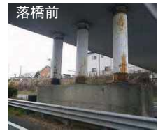
写真-3 府領第一橋のロッキング橋脚と落橋の状況 (県道小川嘉島線・府領第一橋)
