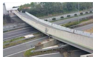
写真-1 県道小川嘉島線 府領第一橋
