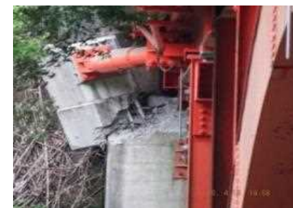
写真-5 県道熊本高森線・大切畑大橋におけるゴム支承の損傷（左） とおおきりはた 国道325号・南阿蘇橋におけるダンパー取付部の損傷（右）
