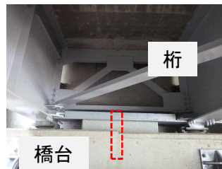
写真-5 アンカーバー のイメージ
