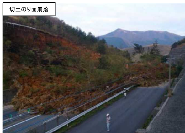
ゆふ (大分自動車道由布市) 写真-2 切土のり面崩壊状況
