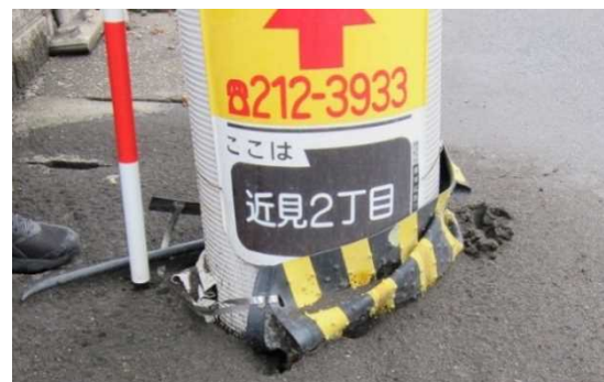
写真-3 液状化による電柱の沈下
