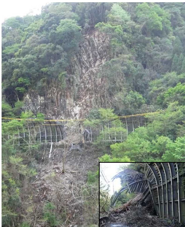
写真-1 落石防護施設では防ぐことができず、路面に岩塊が到達
