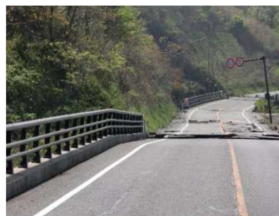
写真-4 県道熊本高森線・依山大橋における橋台の沈下
