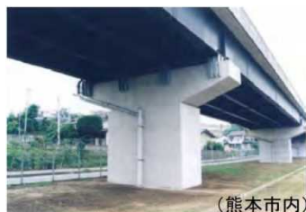
写真-3 国道3号 跨線部
