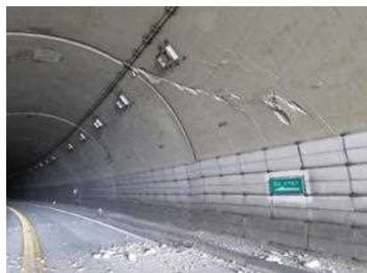
写真-1 覆工コンクリートせん断ひび割れ
