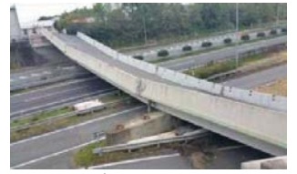
写真-3 府領第一橋のロッキング橋脚と落橋の状況 (県道小川嘉島線・府領第一橋)
