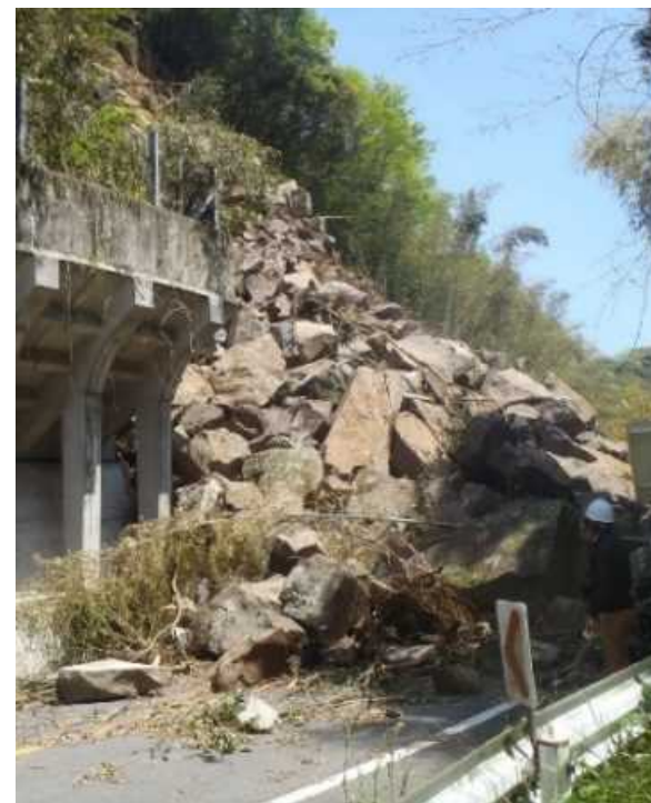
写真-3 落石防護施設の脇に崩落し、車線を完全に塞いでいる溶結凝灰岩
