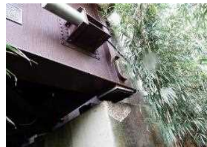
写真-5 県道熊本高森線・大切畑大橋におけるゴム支承の損傷（左） とおおきりはた 国道325号・南阿蘇橋におけるダンパー取付部の損傷（右）
