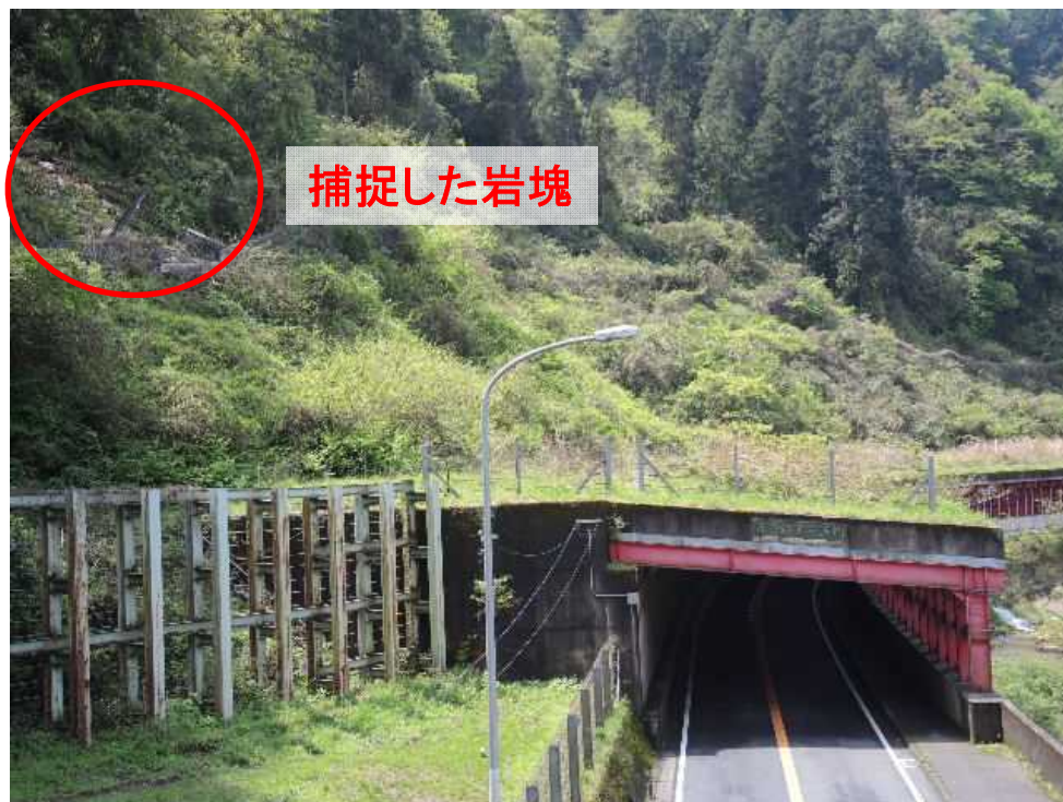
写真-1 斜面崩壊状況
