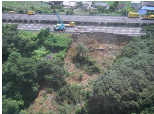
写真-1 盛土崩壊状況
