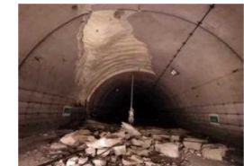
写真-1 覆工コンクリートの崩落（俵山トンネル）
