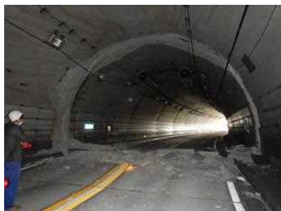
写真-2 覆工コンクリート崩落及び盤ぶくれ
