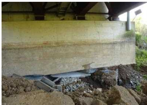
写真-2 橋台周辺での地盤 変状による橋台の沈下 たわらやま (県道熊本高森線・俵山大橋)
