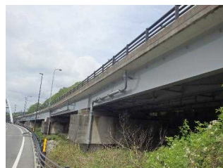
写真-4 阿蘇口大橋 (国道57号)
