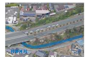
写真-9 九州自動車道における盛土崩壊の状況
