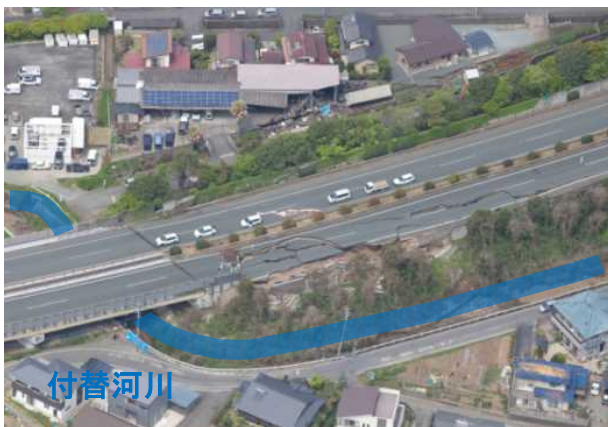
写真-2 九州自動車道の盛土崩壊全景
