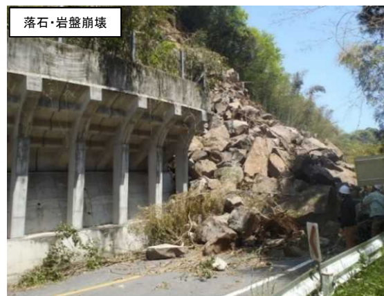
みふねまちたきお (国道445号御船町滝尾) 写真-4 岩盤崩壊の状況
