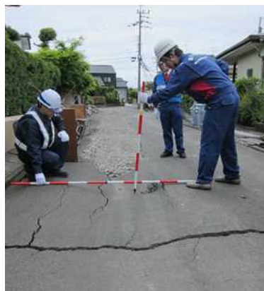
写真-2 液状化によると考えられる路面陥没
