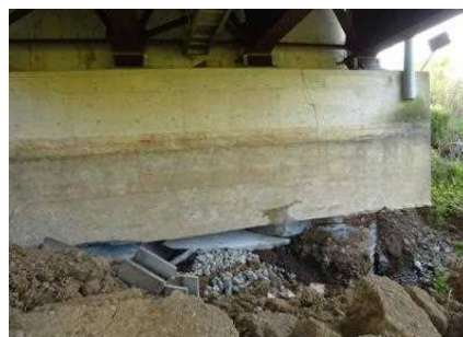
写真-4 県道熊本高森線・依山大橋における橋台の沈下
