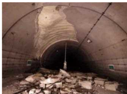
写真-3 覆工コンクリート崩落
