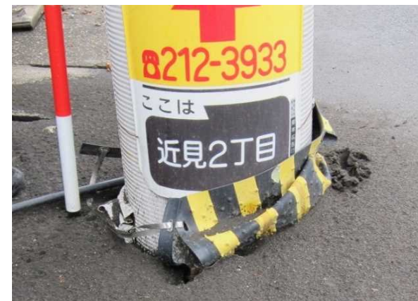
みなみくちかみ (町道 熊本市南区近見) 写真-6 電柱の沈下の状況
