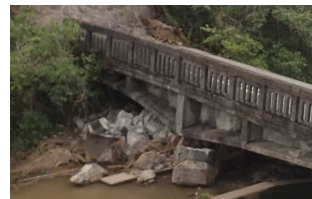
写真-2 平田・小柳線 田中橋
