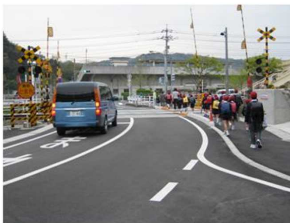
＜歩道拡幅(島根県浜田市)＞
