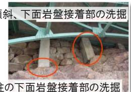
Co支柱の下面岩盤接着部の洗掘
