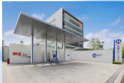
＜水素ステーション＞
