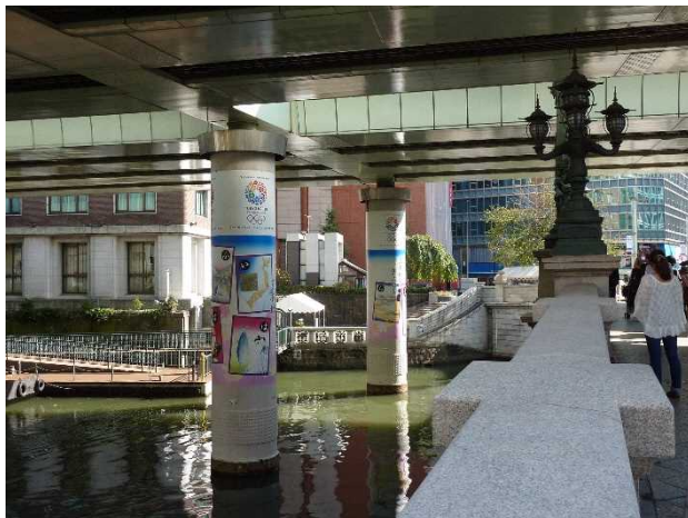
首都高速道路（中央区日本橋）
