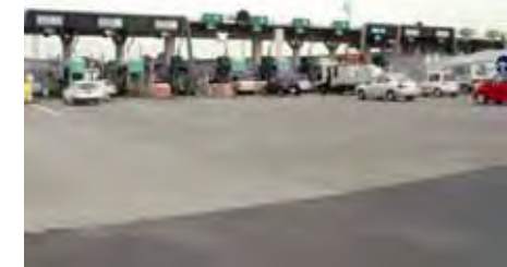
新座本線料金所 (関越自動車道)
