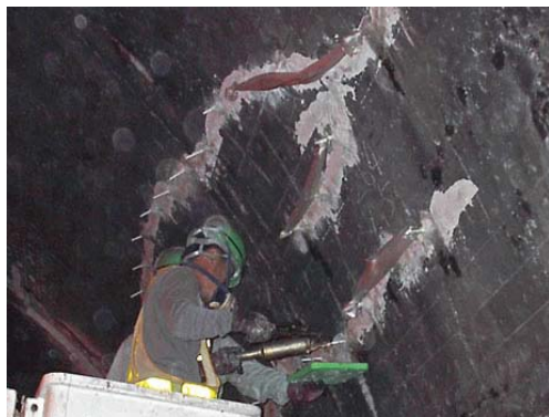
ひび割れ注入による補修
