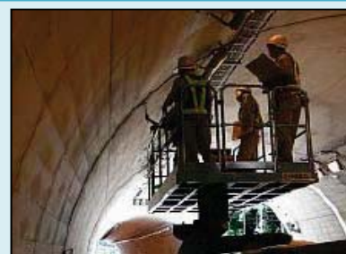
(道路構造物の点検)
