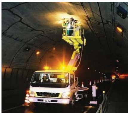
近接目視による ひび割れ探査
