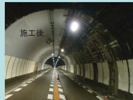
【吹き付けコンクリート(繊維補強)に よるはく落防止工】
