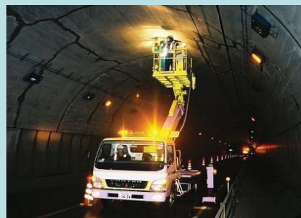
【近接目視によるひび割れ探査】
