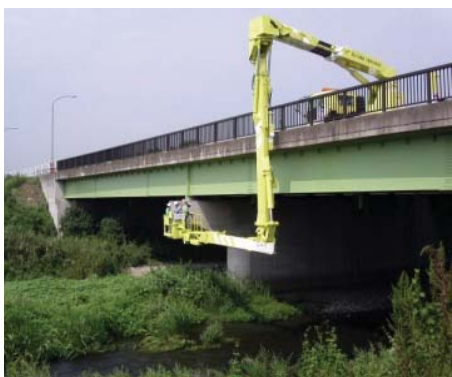
橋梁点検車を使った 橋梁点検
