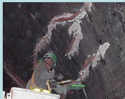
【クラック注入による ひび割れ補修】
