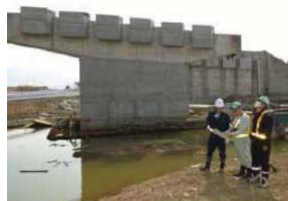
津波により流出した橋の調査
