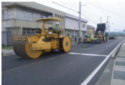
切削オーバーレイによる補修
