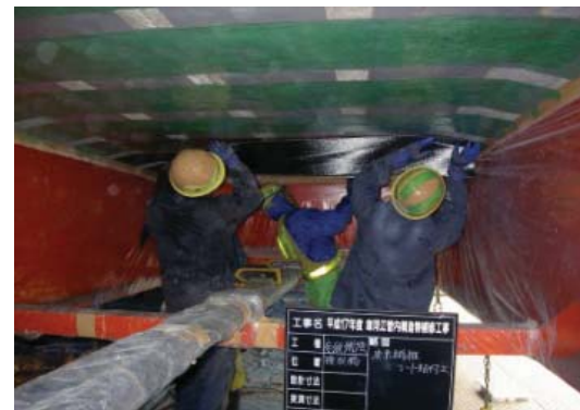
炭素繊維シートによる補修
