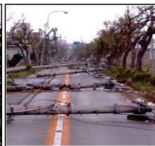
(台風による道路の被災状況)
