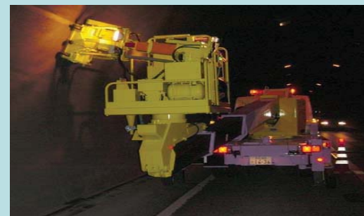
【検査車による非破壊検査】
