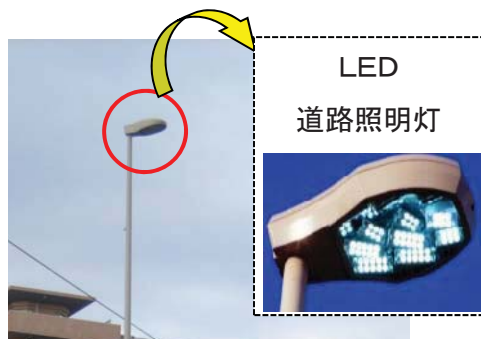
LED道路照明灯の整備
