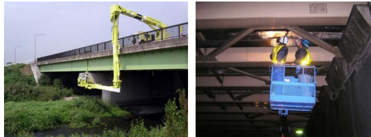
橋梁点検車を使った橋梁点検
