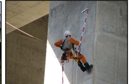
目視による 定期点検
