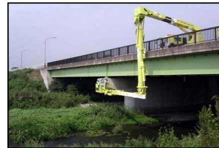
橋梁点検車による 定期点検
