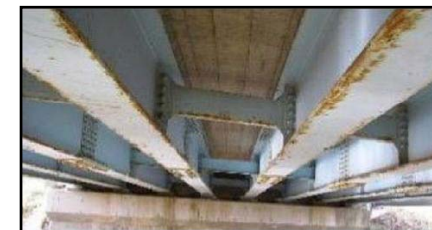
鋼材の腐食
