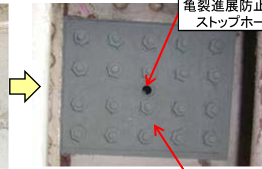
あて板による補修
