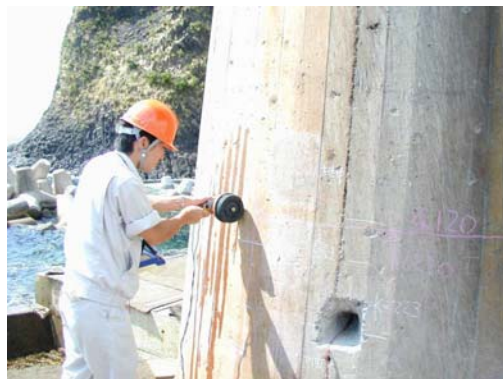
非破壊検査による橋脚内部の検査
