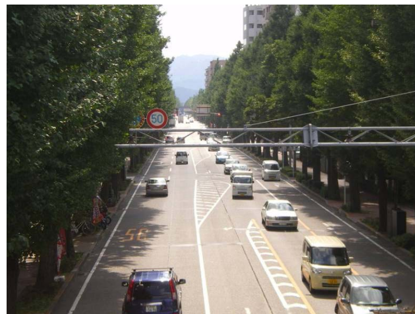
国道20号(東京都八王子市内)
