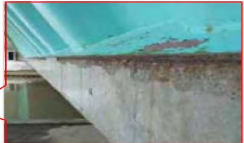
▲波形鋼板ウェブ腐食事例
