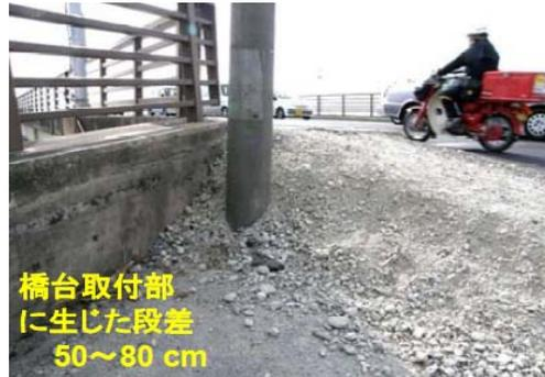
橋台背面盛土の沈下の事例
