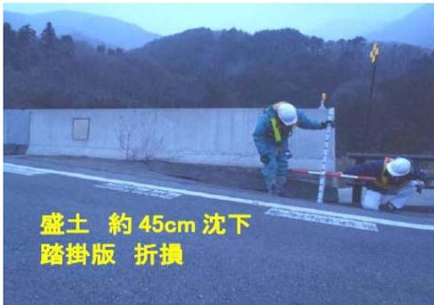
橋台背面盛土の沈下による段差及び踏掛版の損傷の事例
