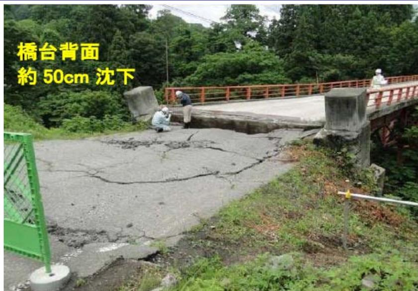
▲橋台周辺の土塊の沈下と橋台等の傾斜
