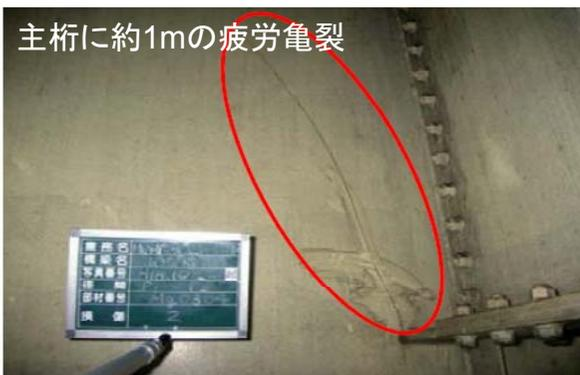
▲主桁の疲労亀裂の事例
